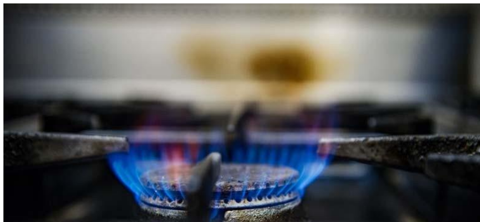
Blaue Gasflamme am Gasherd bei ausreichender Verbrennungsluftversorgung (Bildquelle: wdr-image-101595~_v-gross20x9)
