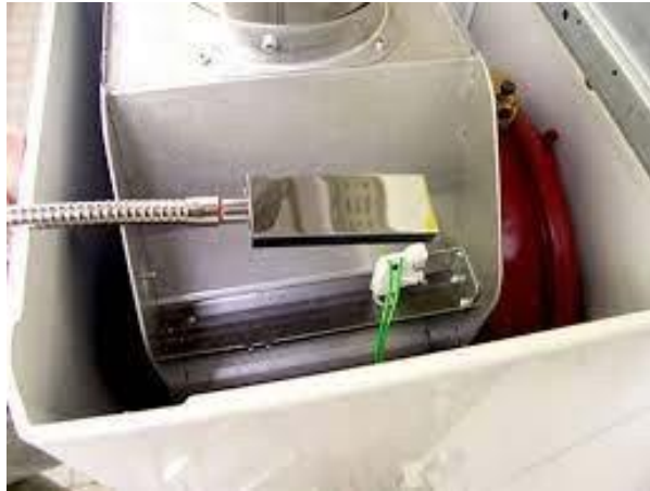
Bild – Strömungssicherung und Austritt der Abgase mit Technik (Bildquelle: sbz-monteur.de)
